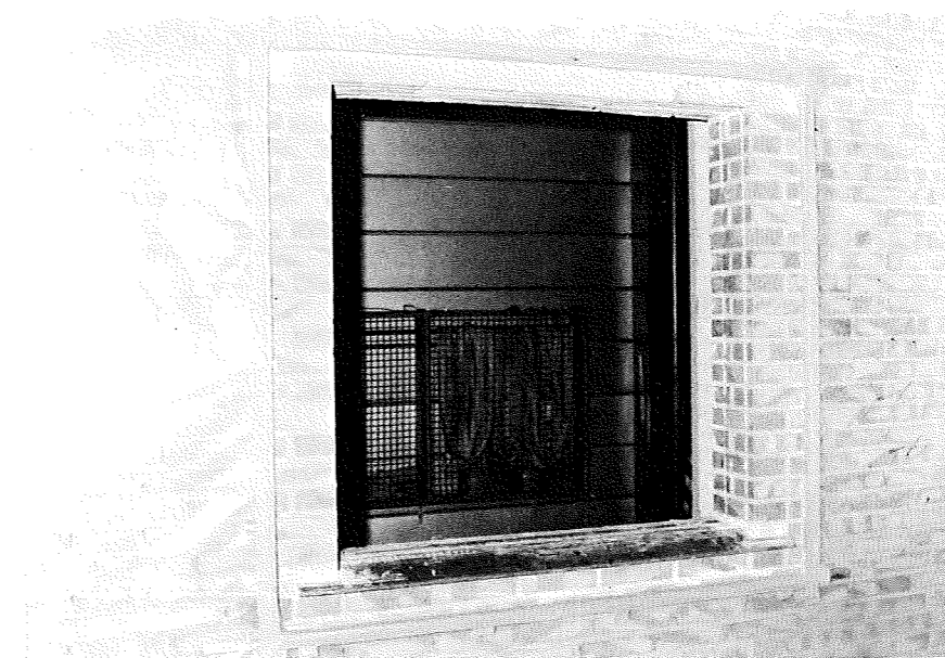
Figur 7. Muren omkring vinduet blev på den udvendige side afdækket med fast-tapet plastfolie inden forsøgene.
