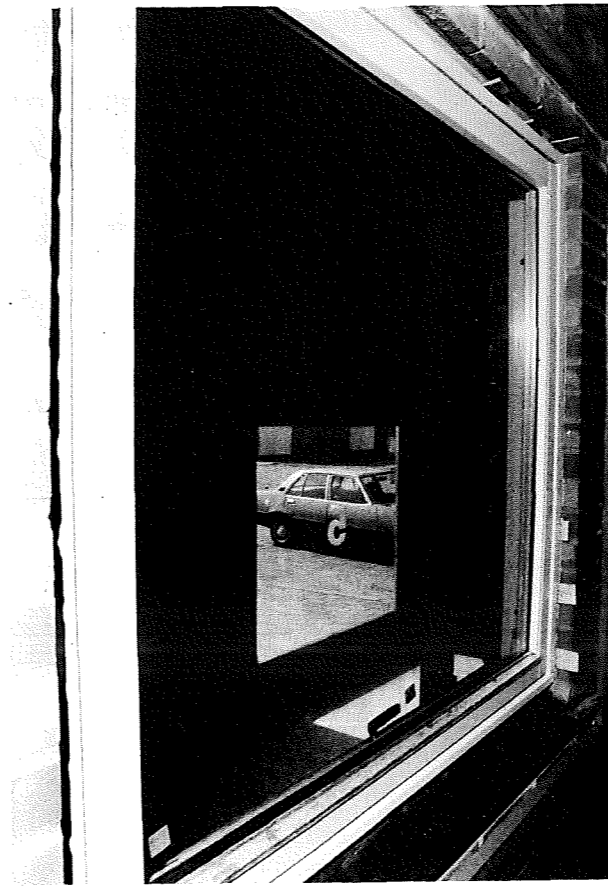
Figur 12. Kiler anbragt i fjerne- ste lodrette fuge og over vinduet.
