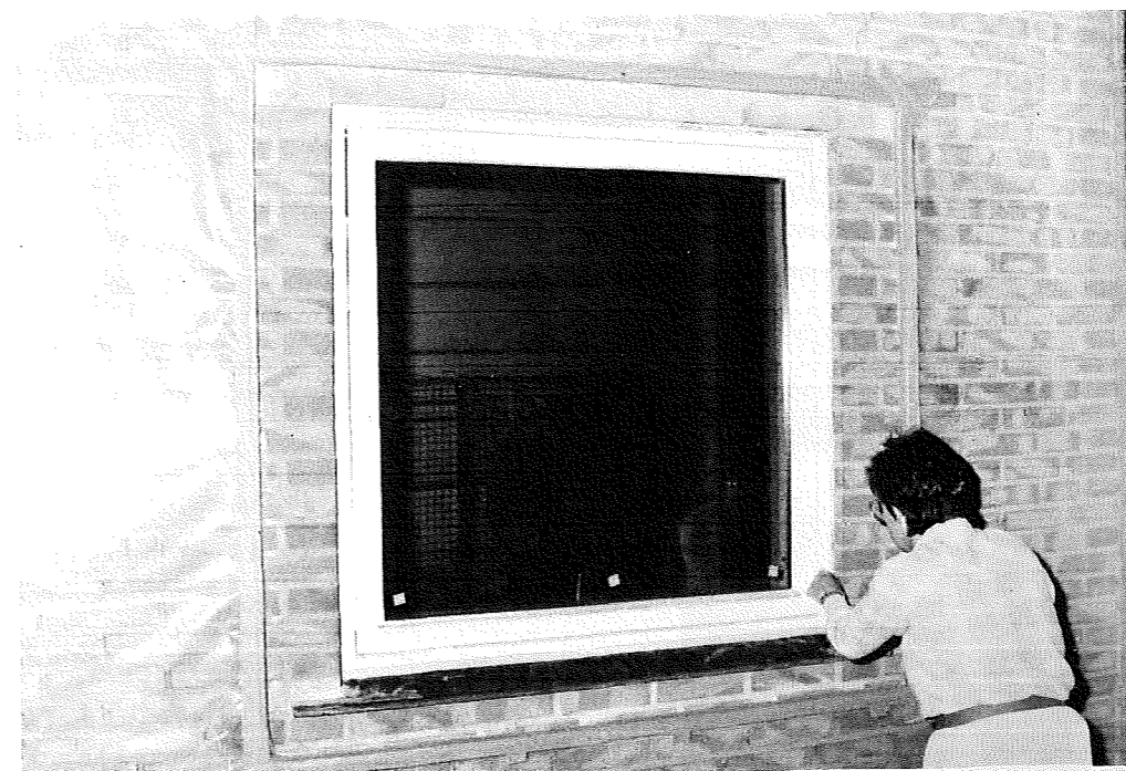
Figur 9. Vindue indbygget i forsøgsvæg.
