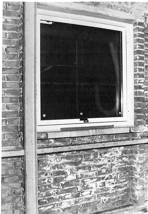
Figur 10. Mur med vindue set indefra. Stålprofilen langs vinduet er anbragt for at forhindre, at væggen vælter som følge af vindtryk.
